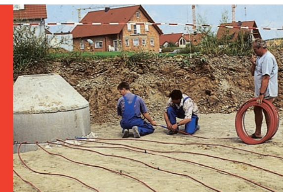
Verlegung von Erdkollektoren
